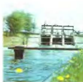
Участок Северо- Крымского канала
